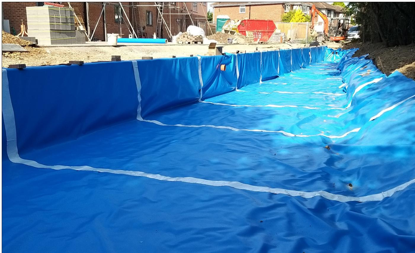
Eine synthetische Folie aus plastifiziertem PVC mit einer eingesetzten Lage aus Polyester-Gewebe zur Dimensionsstabilität. Wetter- und UV-beständig.
